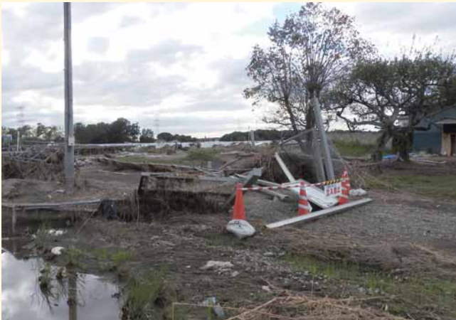
越水現場付近（若宮戸）
